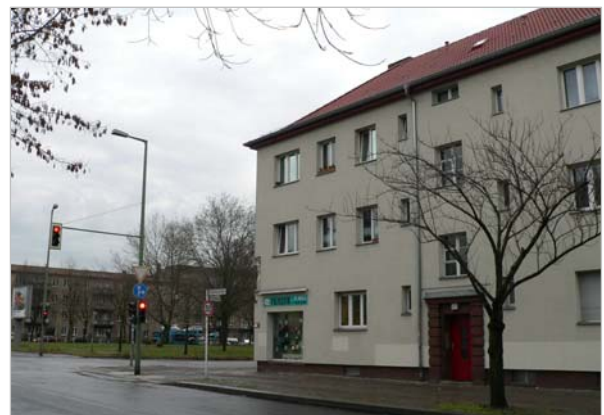
Eckgebäude Hosemannstraße/Ostseestraße nach der Sanierung Foto: Weeber+Partner
